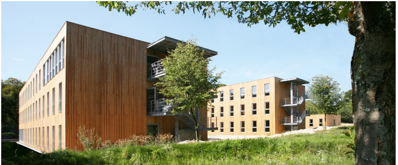
Neubau für die 5. Hundertschaft in Modulbauweise, BEPO Eichstätt (Foto © StBA IN)
