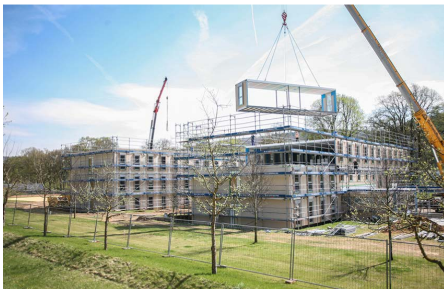
Montage der Module (Foto © StBA IN)
