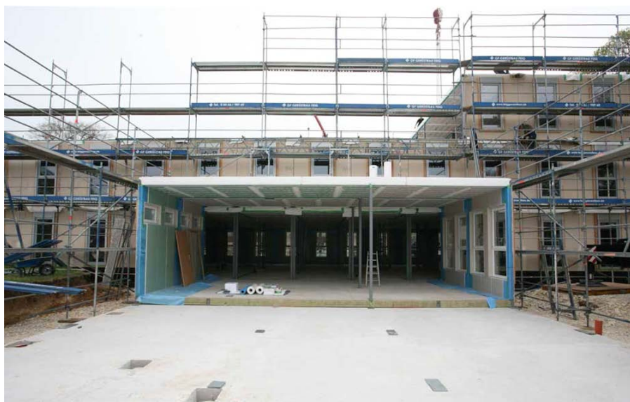
Montage der Module (Foto © StBA IN)
