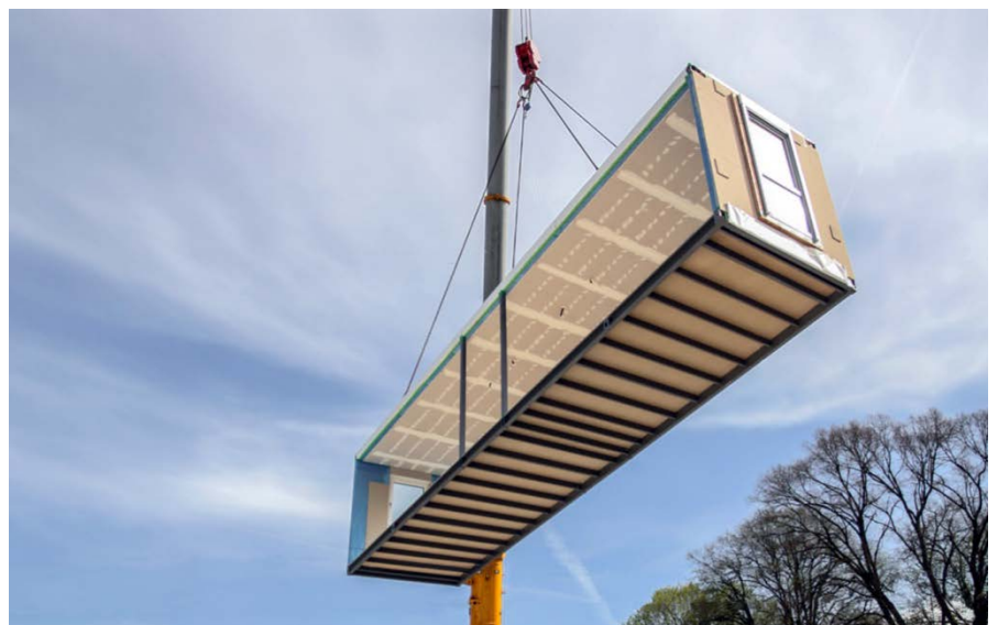
Montage eines Moduls (Foto © StBA IN)
