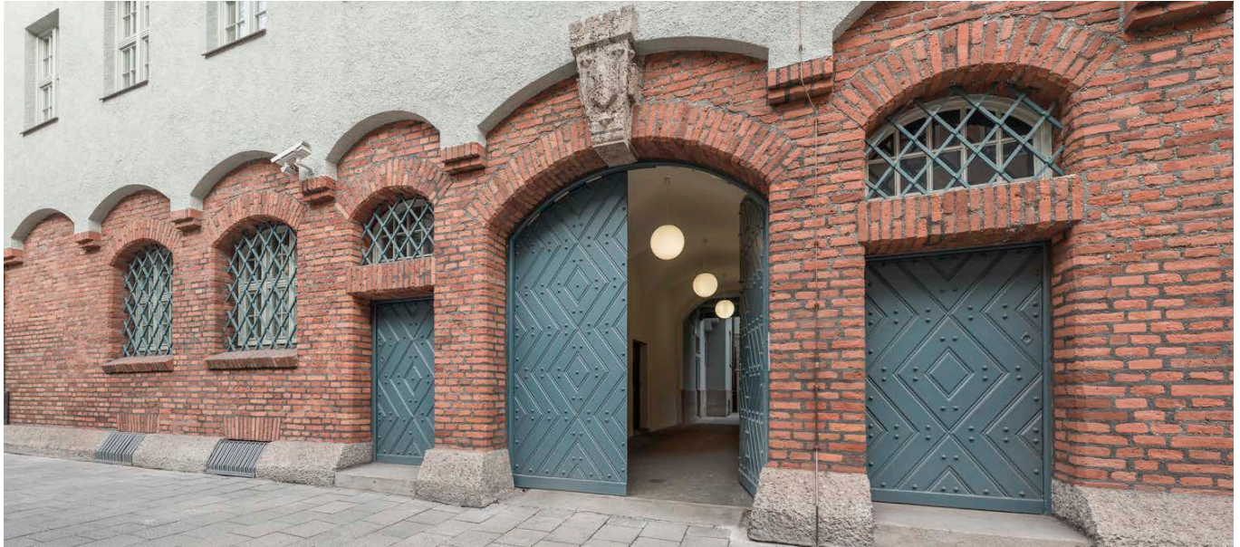
Hofzufahrtbereich (© Peter Langenhahn)
