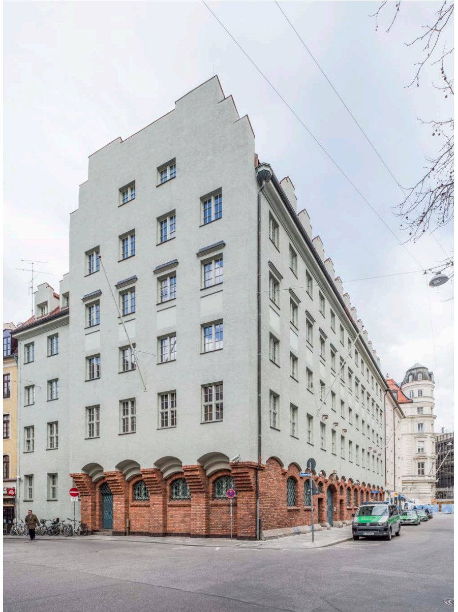
Straßensituation (© Peter Langenhahn)
