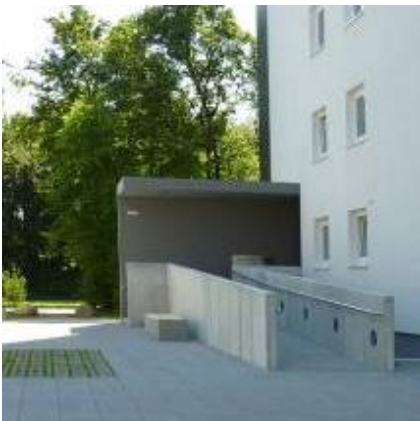
Rampe zum Eingangsbereich (Foto: Oliver Seischab, OBB) © Experimenteller Wohnungsbau
